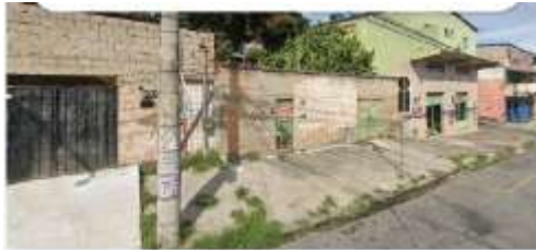
Rua Marco Aurelio 230
