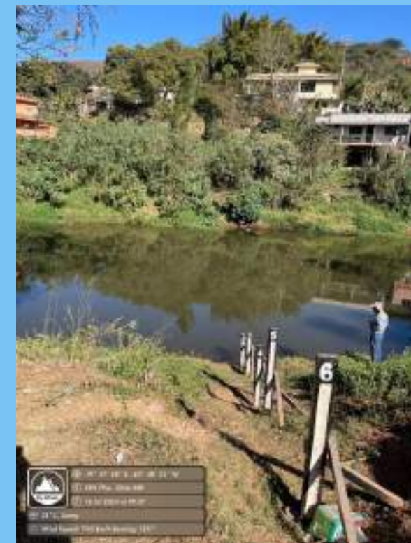
Estação de Raposos: Equipamentos de coleta e transmissão de dados e régua linimétrica
