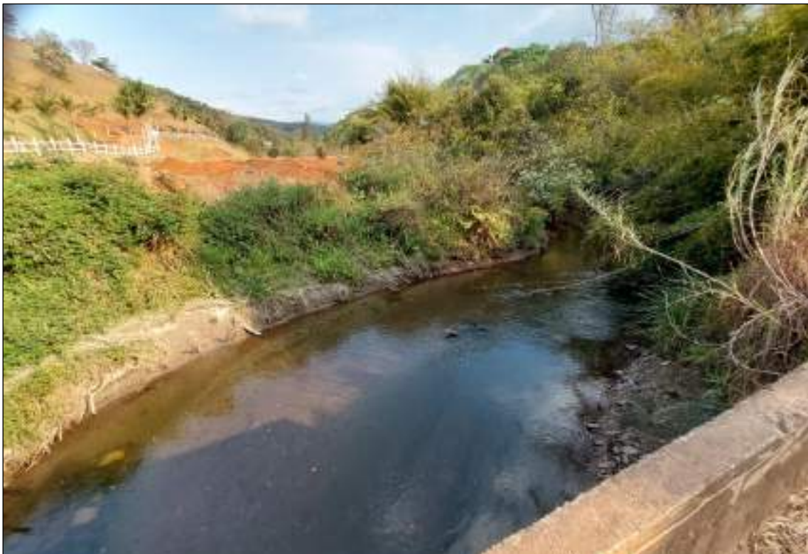
Vista do Rio das Velhas a montante da ponte da Estação Fazenda Água Limpa – Jusante. Notar curva do rio.
