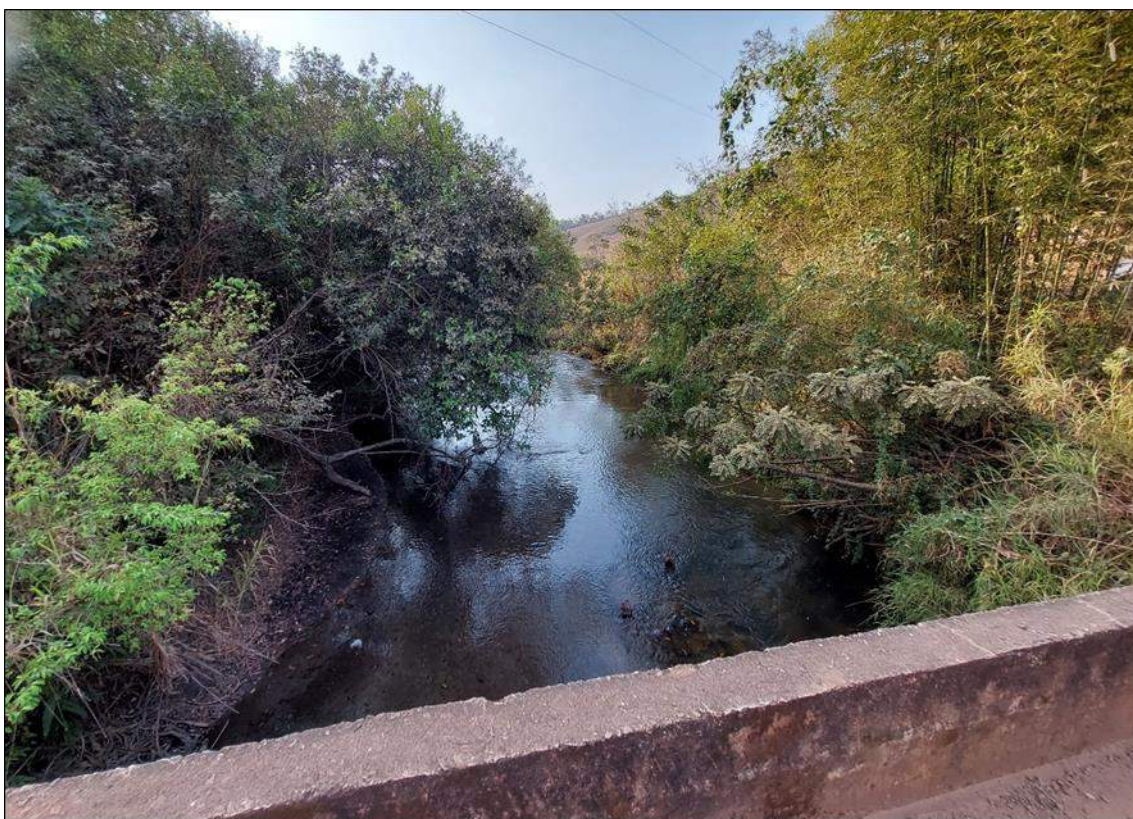
Vista do Rio das Velhas a jusante da ponte da Estação Fazenda Água Limpa – Jusante Foto de Euler Cruz – setembro/2024
